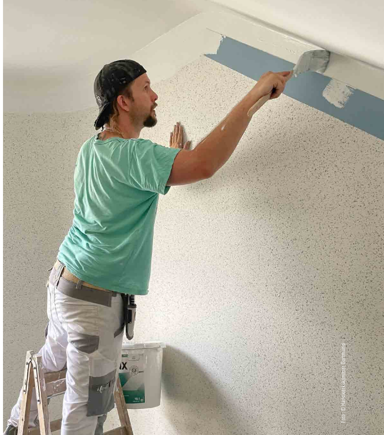
Marcel Pawlowski führt die ersten Vorarbeiten für den neuen Rauputz aus.
