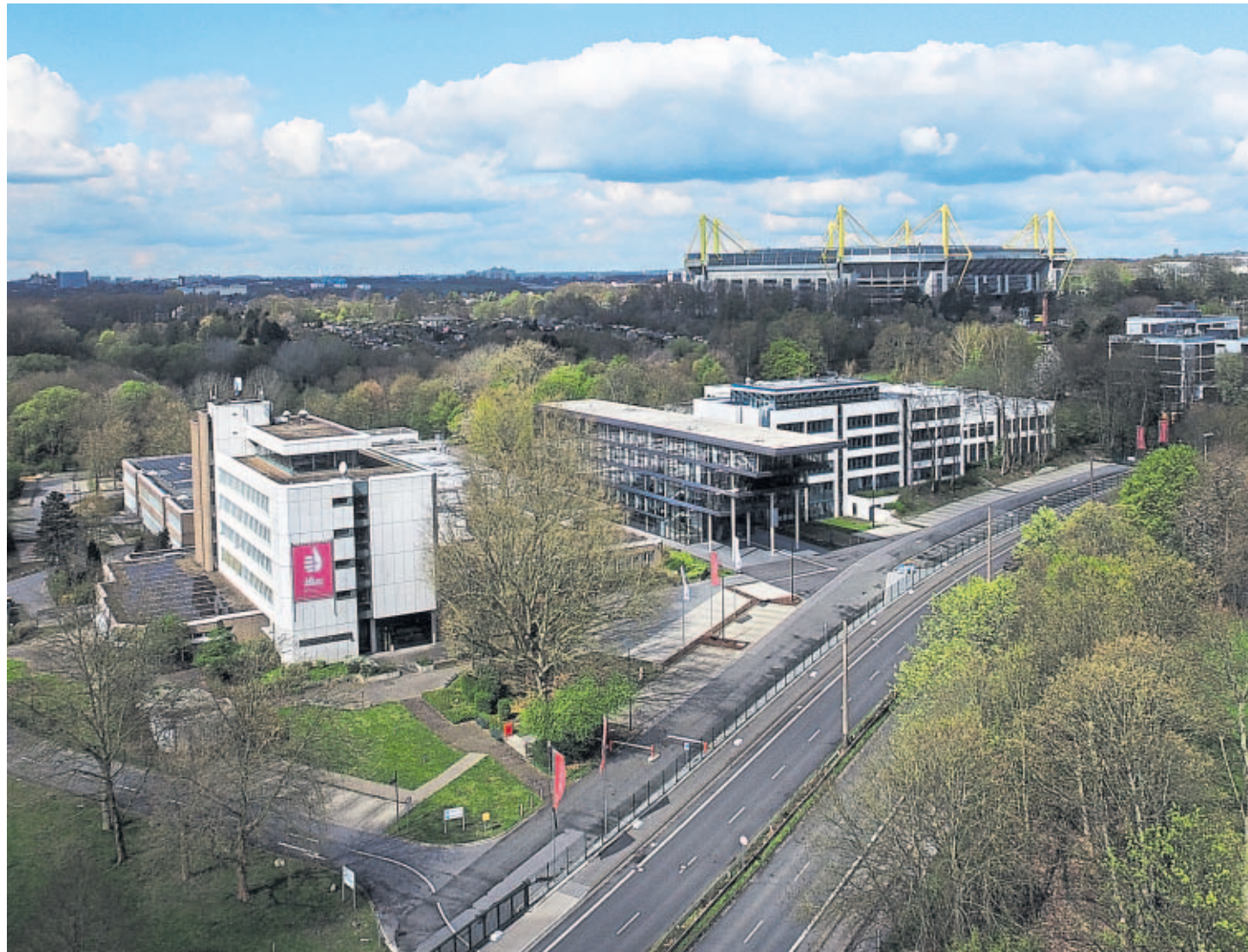
Auf dem HWK-Gelände an der Dortmunder Ardeystraße soll ein Handwerkskunstwerk nachhaltig in den Bestand der HWK integriert werden
